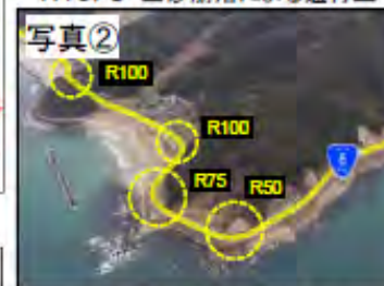
平面線形不良区間が連続
