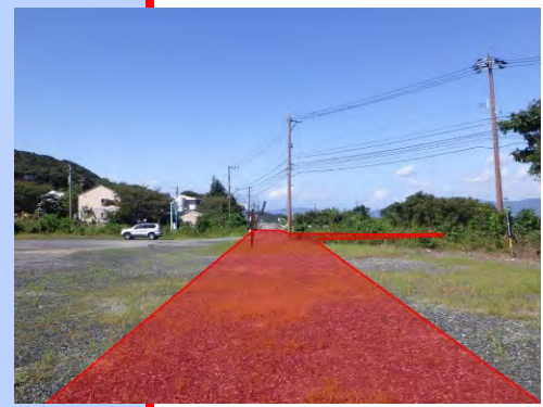
②トンネル部 手側入口
